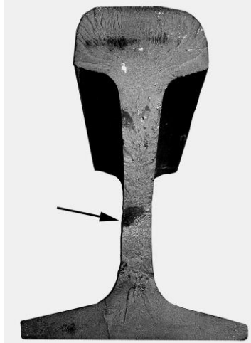
Дефект 76.3/56.3 Излом рельса в эксплуатации от усталостной трещины, возникшей от дефекта сварки в сварном шве в шейке (показанного стрелкой)
